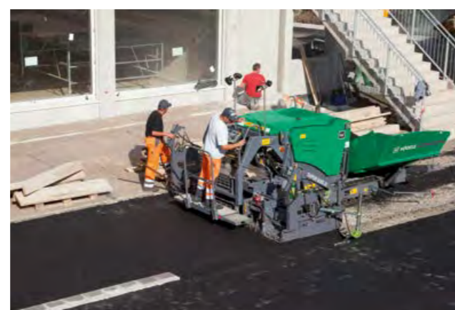
BAU VON PLÄTZEN
