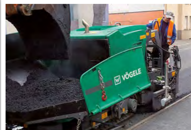
ASPHALTEINBAU ZWISCHEN STRASSENBAHNSCHIENEN
