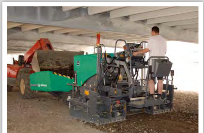
HERSTELLUNG DES UNTERBAUS FÜR PFLASTERSTEINE
