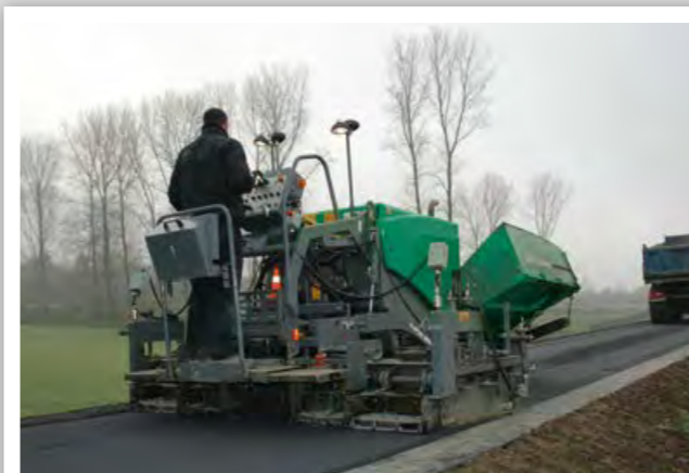
ASPHALTEINBAU AUF DÄMMEN
