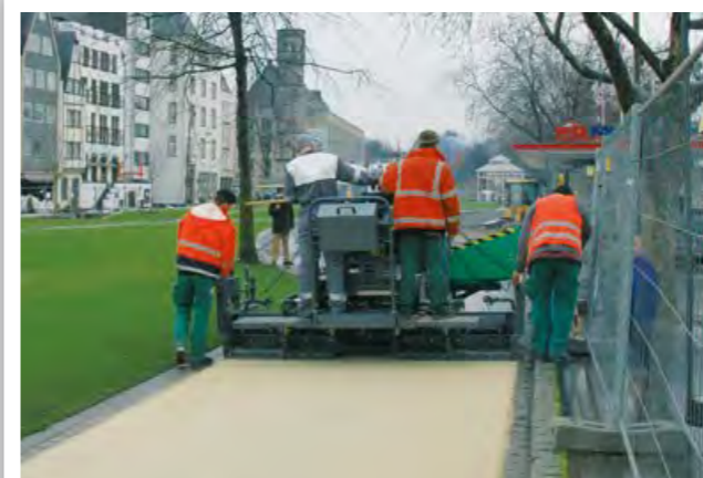
WEGEBAU IN PARKANLAGEN
