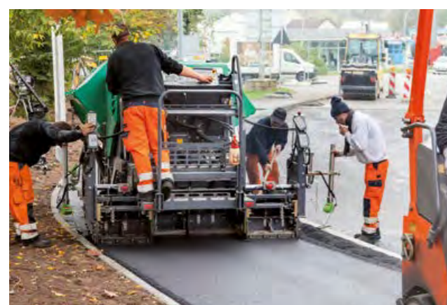
BAU VON WIRTSCHAFTSWEGEN
