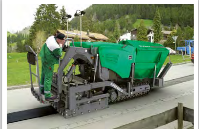
BEFÜLLEN VON KANALGRÄBEN
