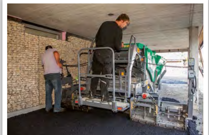
ASPHALTEINBAU IN INDUSTRIEHALLEN
