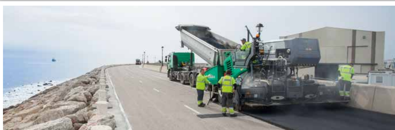
RÉFECTION D'UNE ROUTE DE DIGUE
