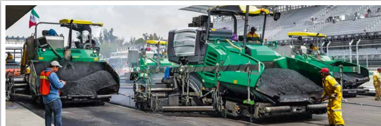
RÉFECTION D'UN CIRCUIT DE COURSE
