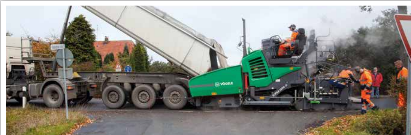
RÉFECTION DE LA CHAUSSÉE DANS UNE ZONE D'HABITATION
