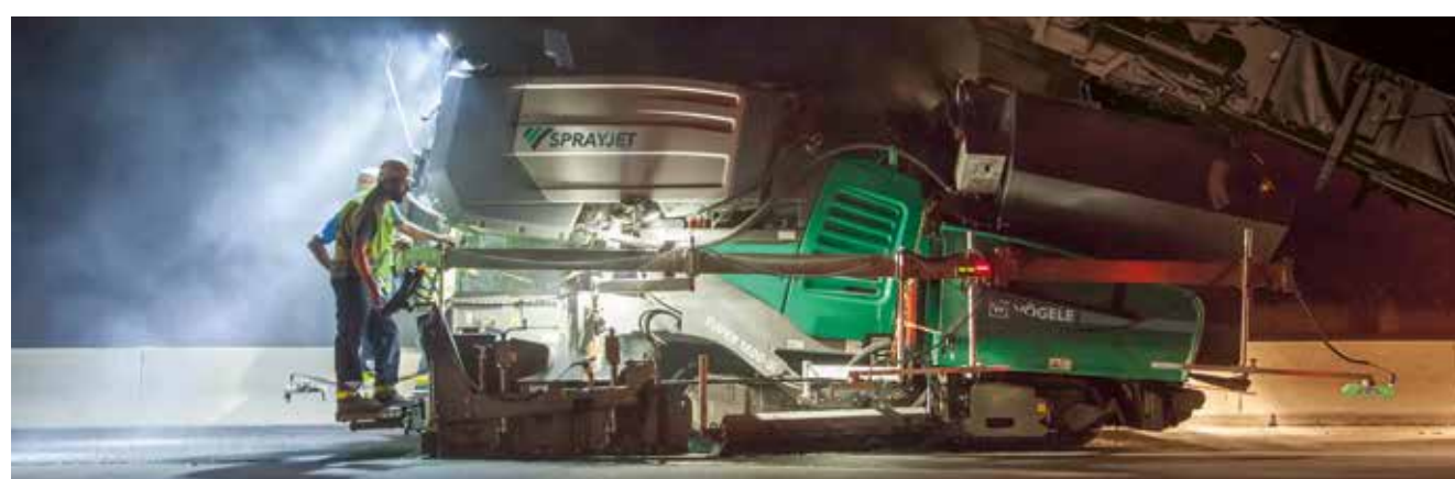
RÉFECTION D'UNE AUTOROUTE
