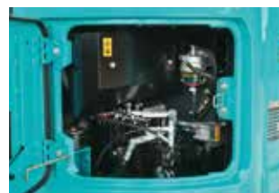
Brandschutzwand zwischen Pumpen- und Motorraum
