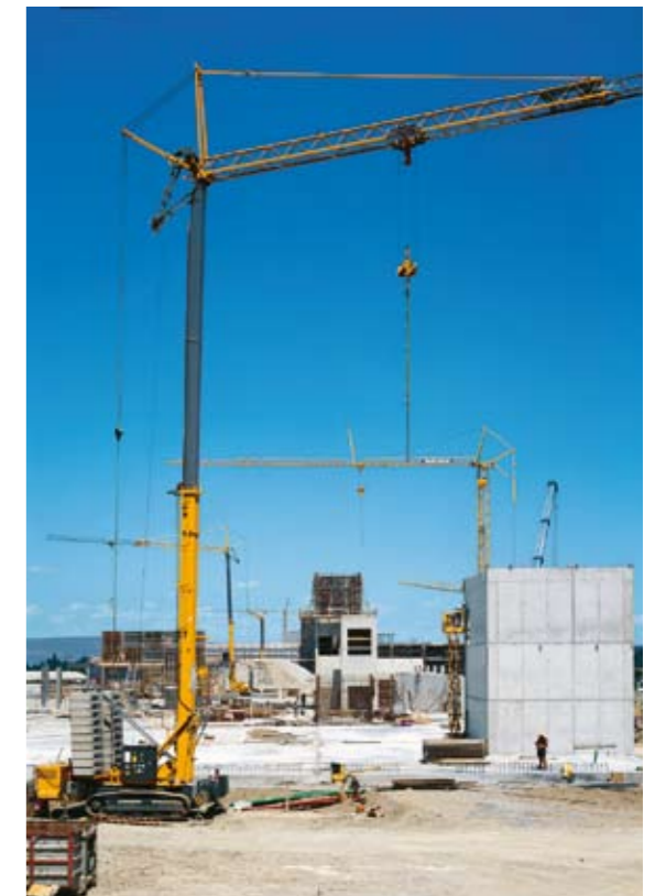
Changement de site rapide : déplacement sur chantiers de grandes envergures.
