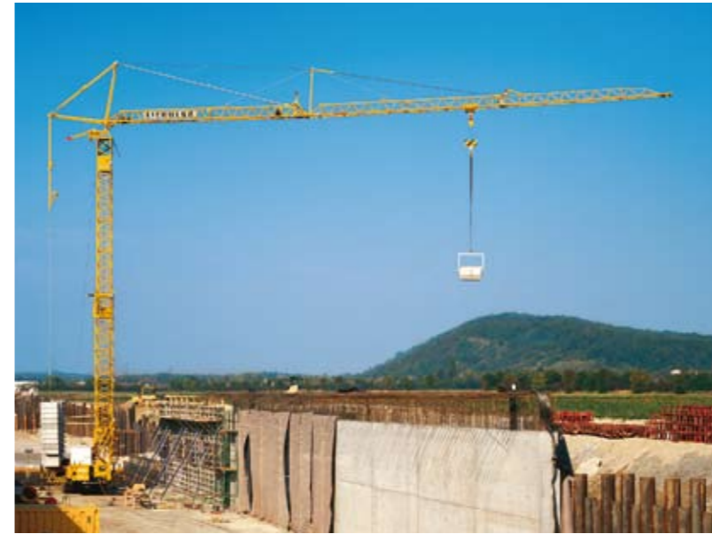
Economique : seule une grue sur chenilles est nécessaire sur le long chantier de construction de tunnel.
