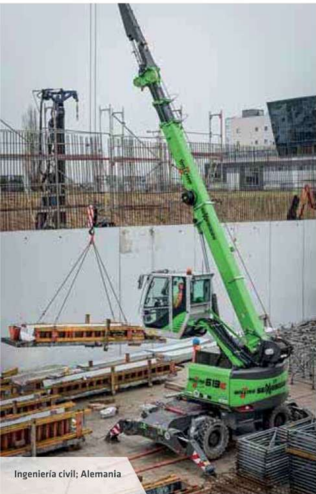
Construcción de edificios; Alemania
